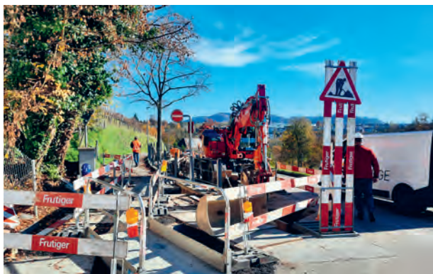
Abwasser- und Wasserleitungersatz an der Reichenbachstrasse
