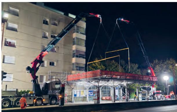
Anhebung des Dachs am Bahnhof Unterzollikofen
