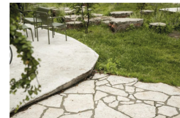
Wegausbildung mit Sichtkante / Vorteile für dem Umgang mit dem Terrain. Klinkerplätze mit Rasenfugen / offenen Fugen
