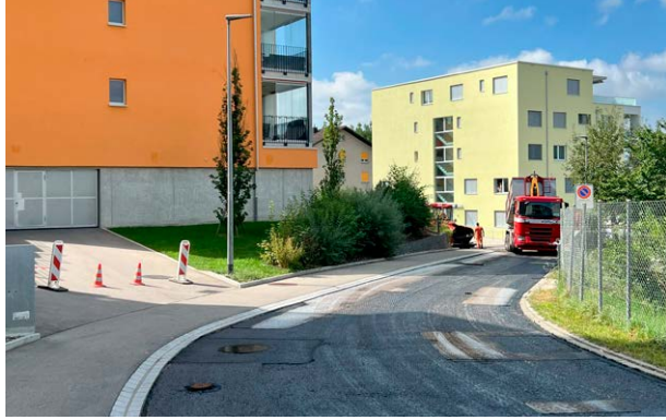
Lätternweg: Lokale Verstärkung der Tragschicht vor Belagseinbau
