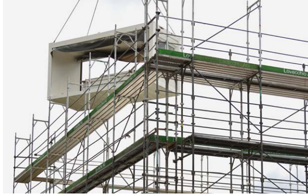
Der Modulbau im Geisshubel entsteht im Eiltempo.
