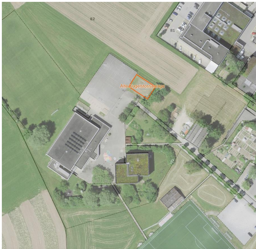
1 Standort Geisshubel Provisorium bei der alten Kugelstossanlage
