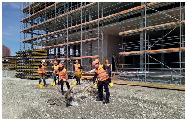
Grundsteinlegung beim Verwaltungsgebäude des Bundesamts für Bauten und Logistik (BBL) in Zollikofen
