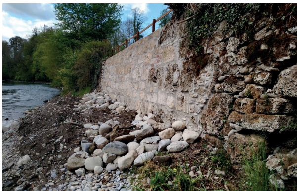
Ufermauer beim Schloss Reichenbach nach Wiederaufbau
