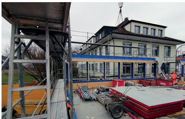
und die Montage des vorgefertigten Holzelements.
