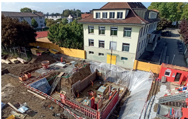
Baustelle Schulraumerweiterung Oberdorf: Die Baugrube
