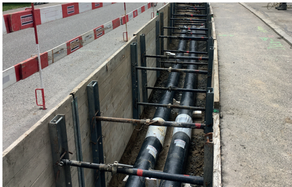
Leitungsbau für die Fernwärme an der Wahlackerstrasse
