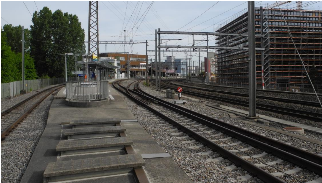
Abbildung 10: Blick von Süden auf die Geleiseanlagen beim Bahnhof Zollikofen. Im Vordergrund die Geleise der RBS (ohne Gefahrgüter), rechts die Geleise der SBB. Das Planungsgebiet befindet sich in der Blickrichtung links.
