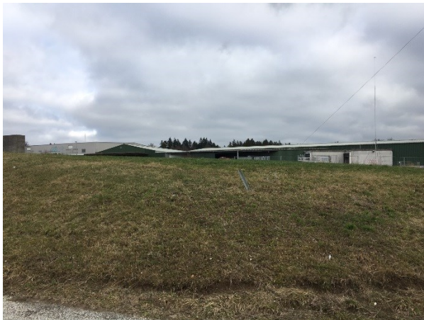
Situation Geländeneigung (Blick zum Gebäude)
