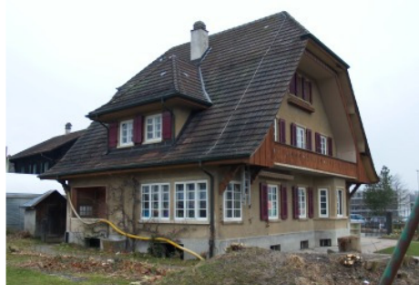
Altes, abgebrochenes Einfamilienhaus.
