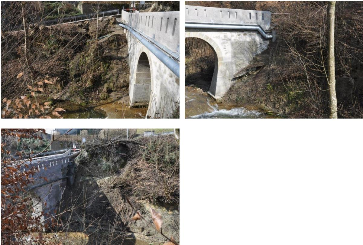
Abbildungen: Durch Erosion beschädigte instabile Böschung im Bereich der historischen Fussgängerbrücke
